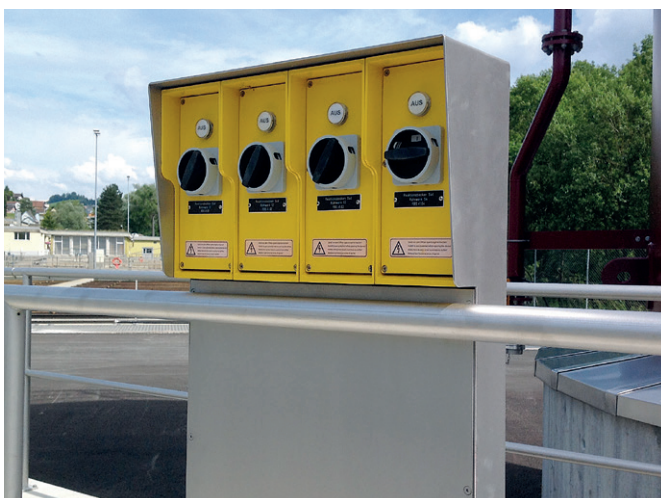
Interrupteurs de sécurité dans boîtier type 2812, jaune, STEP Herisau
